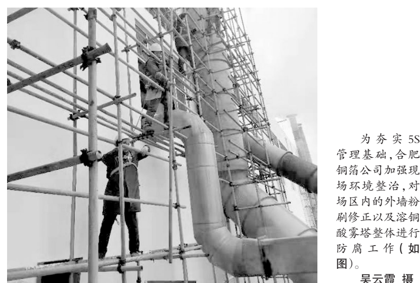
为夯实5S管理基础,合肥铜箔公司加强现场环境整治,对场区内的外墙粉刷修正以及溶铜酸雾塔整体进行防腐工作(如图)。吴云霞 摄
