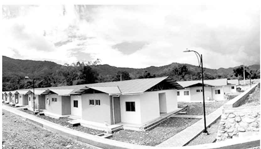
日前,从厄瓜多尔传来喜讯,由铜冠建安厄瓜多尔分公司承建的米拉多铜矿E区3栋宿舍顺利通过竣工验收并交付业主使用。这是铜冠建安厄瓜多尔分公司在海外通过团结努力,精心组织施工取得的又一成果。图为铜冠建安厄瓜多尔分公司在米拉多铜矿新建成并交付的宿舍。王红平 汪锡铜 摄
