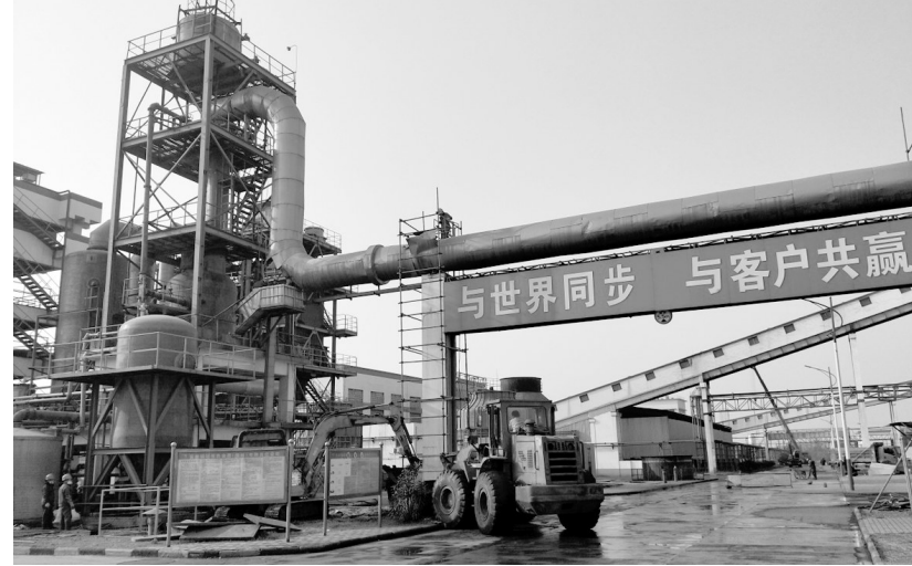
近日,铜冠池州公司铅系统各工序依次进入年度中修阶段,检修计划工期为15天,涉及底吹炉氧枪区及渣线以下炉底砖更换,侧吹炉及烟化炉水套、余热锅炉、电收尘等检修项目260多项。图为制酸系统现场人机配合清淤作业。
