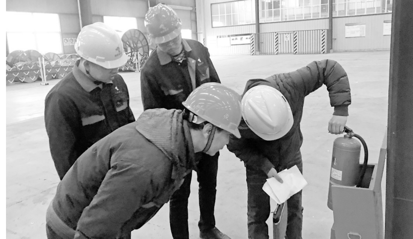
铜冠建安公司员工日前正在检查灭火器(如图)。当日,该公司开展了冬季火灾防控工作检查,针对各单位、各项目薄弱环节和突出问题查缺补漏,确保消防安全。
