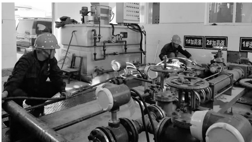
冬季来临,有色动力厂供水一车间盯紧“蓝天碧水”工程,集中骨干力量每天赶赴排泥水处理环保系统生产现场,进行冬季设备维护保养。图为该厂生产骨干正在进行管道疏通作业。
