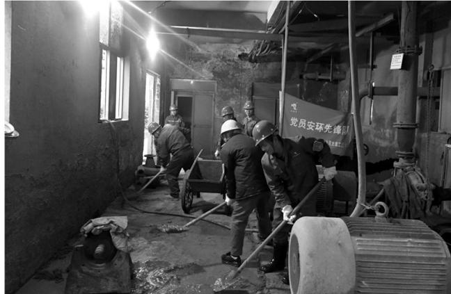
12月23日,天马山矿业公司充填区党员安环先锋队队员对充填系统砂泵房开展5S清洁、整理工作,通过1个多小时的泥沙铲除、清运,队员们共清理了近两吨的陈砂,收到了良好效果。
