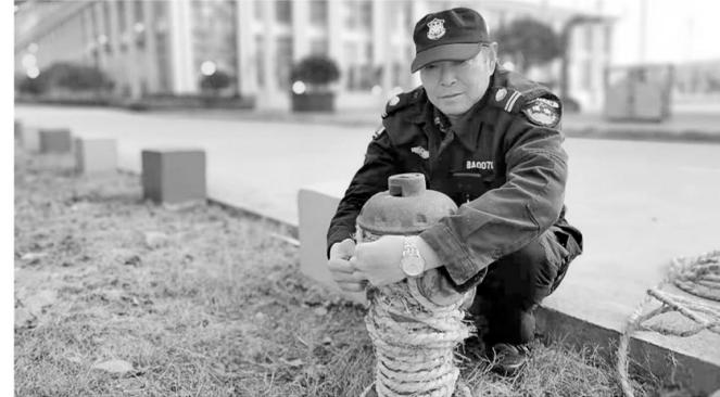
12月21日,铜冠(庐江)矿业公司武保室工作人员正在给室外消防栓换上新的“冬装”(如图)。该公司一贯重视消防安全生产工作,在入冬时节,就给所有消防栓换上新的“冬装”,及时做好防寒防冻工作。
