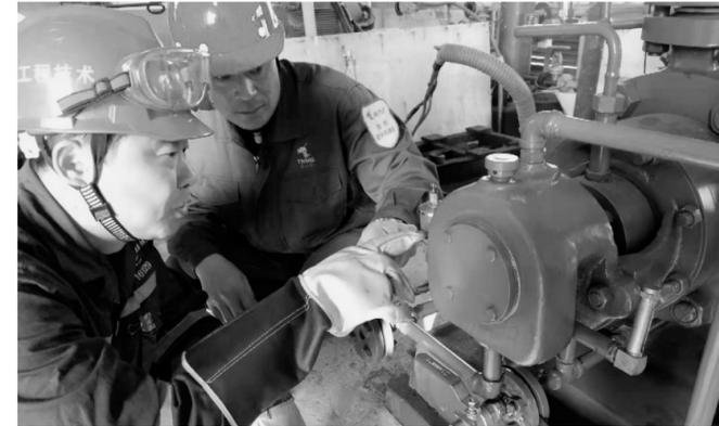
动力厂加强设备环保节能管理,坚持完善设备生产过程中的缺陷与不足,近日该厂更换了热电厂2台能耗大且有漏油现象的工频供油泵,并改造为变频泵,为热电厂系统节能环保和安全运行保驾护航。图为技术人员正在进行变频泵启用前调试工作。
