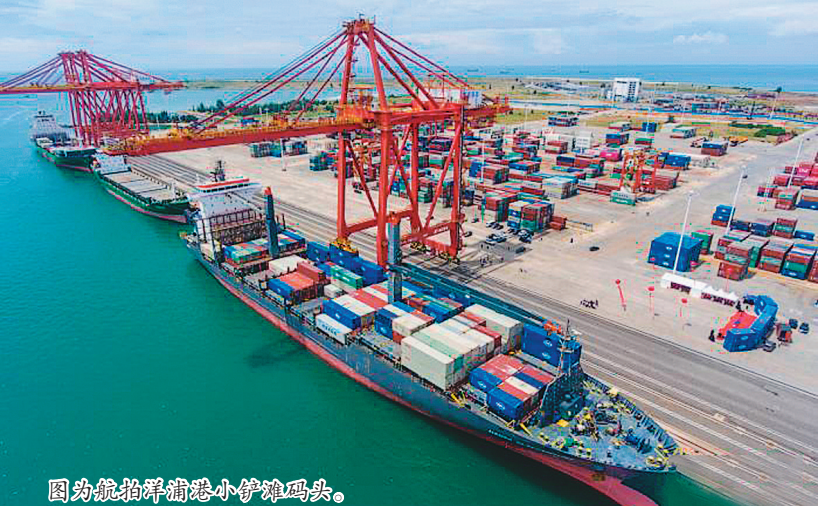
图为航拍洋浦港小铲滩码头。
