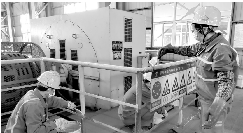
日前,铜山铜矿分公司选矿车间组织党员安环先锋队队员利用生产间隙,对施工现场设备及栏杆进行“换装”。为进一步提升现场5S管理水平,该公司从细节入手,持续开展整理、整顿、清洁工作,有效改善脏乱差现象。 张 霞 刘 彬 摄
