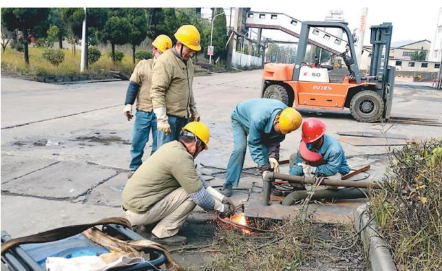
严冬已经到来,为防止发生跑冒滴漏污染现象,确保矿区生产用水管线的安全顺畅,安庆铜矿除了做好管道的正常检查、维护外,还组成应急小组,每天展开巡查,一旦发现跑冒,立即实施维护整改,绝不让生产水流失到地面造成环境污染。图为该矿管道维护人员正在对发现的破损管道进行修复。
