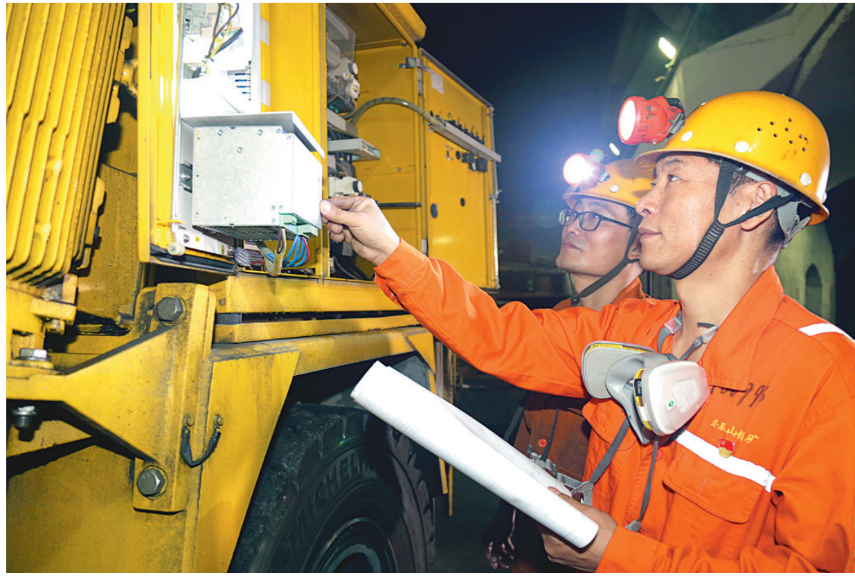
11月30日,冬瓜山铜矿井下负850米维修大库,该矿掘进一区一线职工交接班时正在对281凿岩台车电控柜进行仔细检查,做好作业前的设备点检工作,确保设备保持良好运行状态,为全区完成全年生产任务提供有力保障。截至11月底,该区已完成掘进量75400立方米,超年计划0.53%;支护挂网3.56万平方米,超年计划61.4%;支护锚杆2.76万根,超年计划37.9%,圆满完成了全年生产任务。
