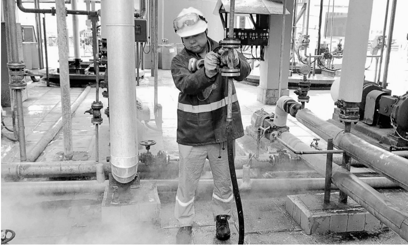
10月22日,金冠铜业分公司奥炉硫酸车间组织人员对脱硫离子液管道蒸汽伴热系统进行试开查验(如图)。针对气温日渐转冷,该车间提前做好防寒防冻措施,确保入冬后设备生产正常运行。
