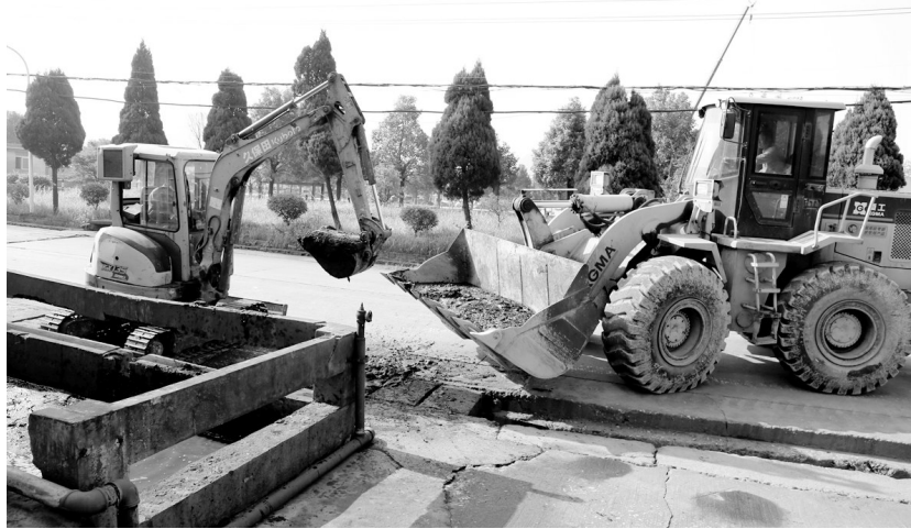
安庆铜矿对拉运矿产品的货车在出库时进行必要的冲洗,将车身和车轮上沾染的矿产品清洗干净,让车辆保持干净和货仓封闭状态上路,既做到了“绿色”运输,又让冲洗下来的矿产品得到了有效收集,每年回收有价精砂产品20余吨,抢救边缘效益价值5万余元。图为员工正在对清洗池里冲洗下来的矿产品进行清理收集。
