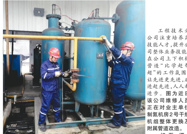
工程技术分公司注重培养高技能人才,提升公司整体业务技能,在公司上下积极营造“比学赶超”的工作氛围,让先进更先进,后进赶先进,人人都进步。图为近日该分公司维修人员正在对业主单位制氮机房2号干燥机组整体更换及附属管道改造。
