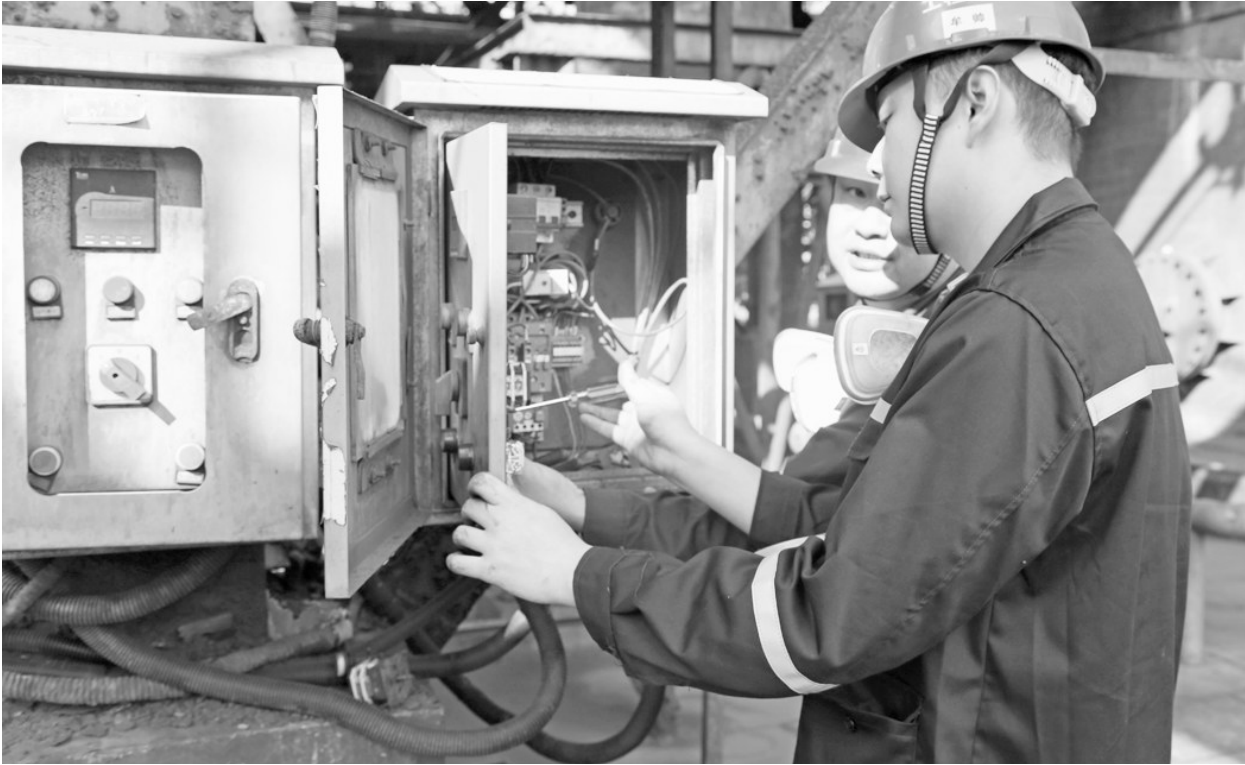
铜冠冶化分公司厂区内协力单位人员正在检测电气设备(如图)。铜冠冶化分公司在保障设备稳定运行上,结合TPM管理对所有设备采取日常点巡检、润滑、防腐、定期查(试)漏、维修等措施,实现设备“外见本色、内无缺陷”,提高了设备管理质量。
