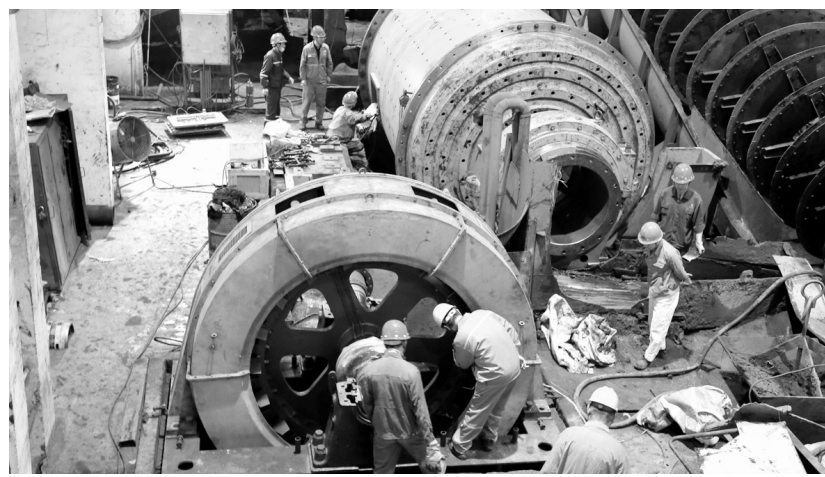
日前,安庆铜矿开展年终设备检修。针对今年检修大小项目多达100多项,且交叉作业多、高空作业多、狭窄空间作业多及维修技术要求高等情况,该矿制定了每一项检修举措并组织好实施,保证检修达到安全、质量和按计划完成,为年底生产任务完成和来年生产顺畅夯实基础。
