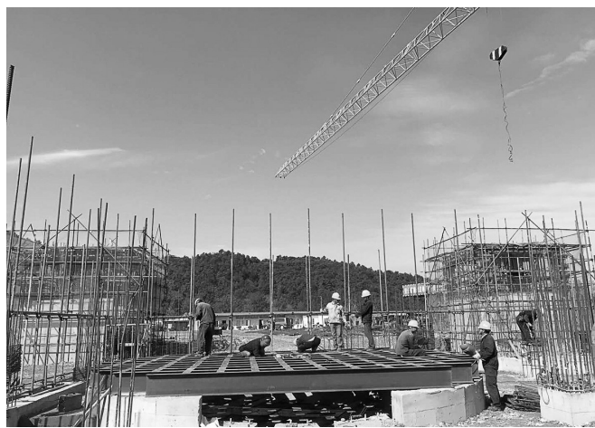
10月5日,铜冠建安公司第二建筑工程事业部承接的冬瓜山铜矿新辅助井井塔工程正在进行井口封闭钢构制作(如图)。该公司事业部超前准备,精心策划,组织职工利用国庆假期加班加点,努力向前推进工程进度。
