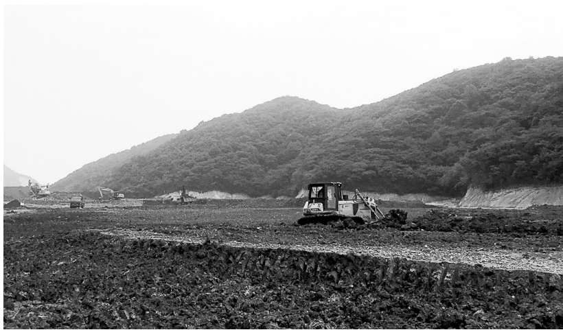
铜冠建安公司第二建筑工程事业部承接的贵湖湾金矿老虎头尾矿库闭库工程准面平整作业正在施工(如图)。该事业部按照设计,开展了排除准面积水,尽量降低库内水位,倒运尾砂、粘土,平整开挖及回填土石方等施工作业,并由坝前向库尾整体推进,为下步防渗膜铺设作业打好基础。
