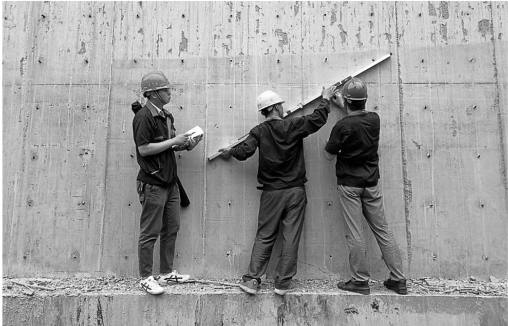
铜冠建安公司质计部人员在冬瓜山铜矿新辅助井井塔工程施工现场检查框架剪力墙的平整度和垂直度。该公司日前组织内审员对质量、环境和职业健康安全管理体系进行了全面审查，并对体系运行情况做出评价，同时要求对审核中发现的不符合项进行原因分析，提出改进措施，完成三标一体管理体系内审工作。
