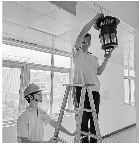
为提高产品质量,有效遏止蚊虫、小咬等进入车间造成产品降级,合肥铜箔公司开展秋季灭蚊行动。通过加大对车间门窗、设备工艺孔、供排风孔等堵漏排查力度,保持车间环境卫生整洁,健全和完善防蚊设施,定期开展物理、化学、生物等防控措施,确保灭蚊消杀保障到位。图为该公司员工正在为走廊安装光催化灭蚊器。 吴云霞 摄
