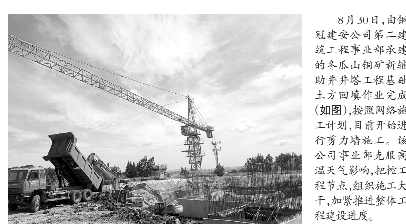
8月30日,由铜冠建安公司第二建筑工程事业部承建的冬瓜山铜矿新辅助井井塔工程基础土方回填作业完成(如图),按照网络施工计划,目前开始进行剪力墙施工。该公司事业部克服高温天气影响,把控工程节点,组织施工大干,加紧推进整体工程建设进度。汪锡铜 摄
