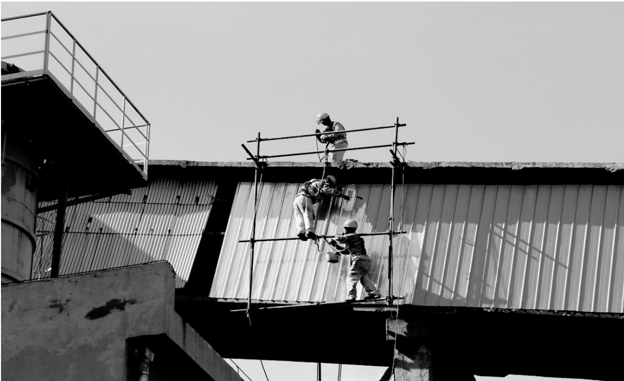
日前,专业人员正在对金隆铜业公司熔炼车间备料室外长皮带廊进行施工(如图)。该走廊两侧塑钢瓦已陈旧破损,为消除安全隐患,同时也为了美化厂区环境,该公司及时更换了崭新的塑钢瓦,使皮带长廊看上去更加美观和安全。
