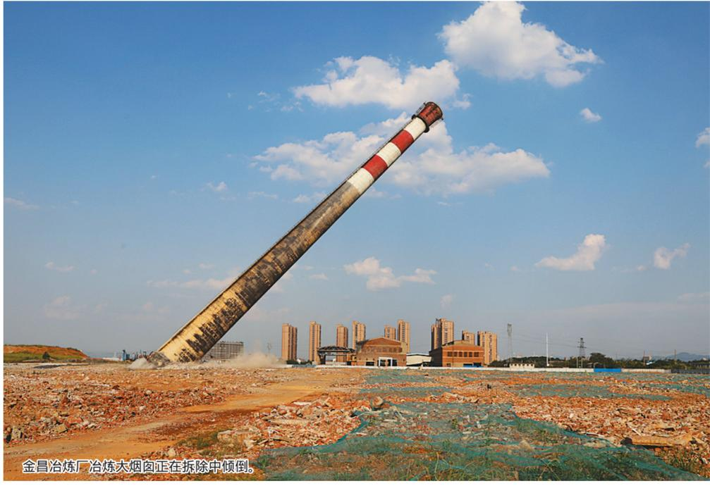
金昌冶炼厂冶炼大烟囱正在拆除中倾倒。
