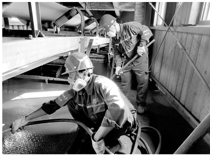
正值持续高温天气,为确保安全文明生产,铜山铜矿分公司运转车间党员安环先锋队争当安全文明生产先锋。近日,队员们冒着高温,对地表斜坡皮带、一号皮带、主井漏斗系统设备进行了安全检查,并对附近区域进行了清扫,使周边环境焕然一新。图为党员安环先锋队队员在清扫一号皮带廊。 潘敬虎 摄
