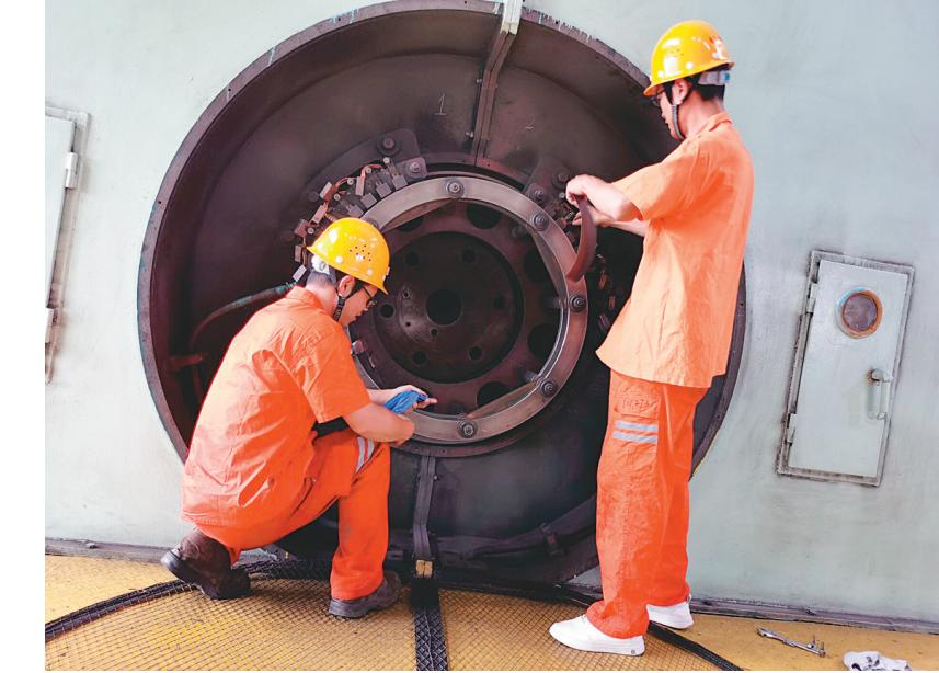
冬瓜山铜矿提升一区坚持每周四对主井及回收井卷扬机进行安全检查,确认急停按钮、过卷开关、安全门、防箕斗张开开关等安全回路装置工作可靠性,擦拭电机滑环及碳刷架,检查碳刷工作可靠性等,确保提升机安全运行。
