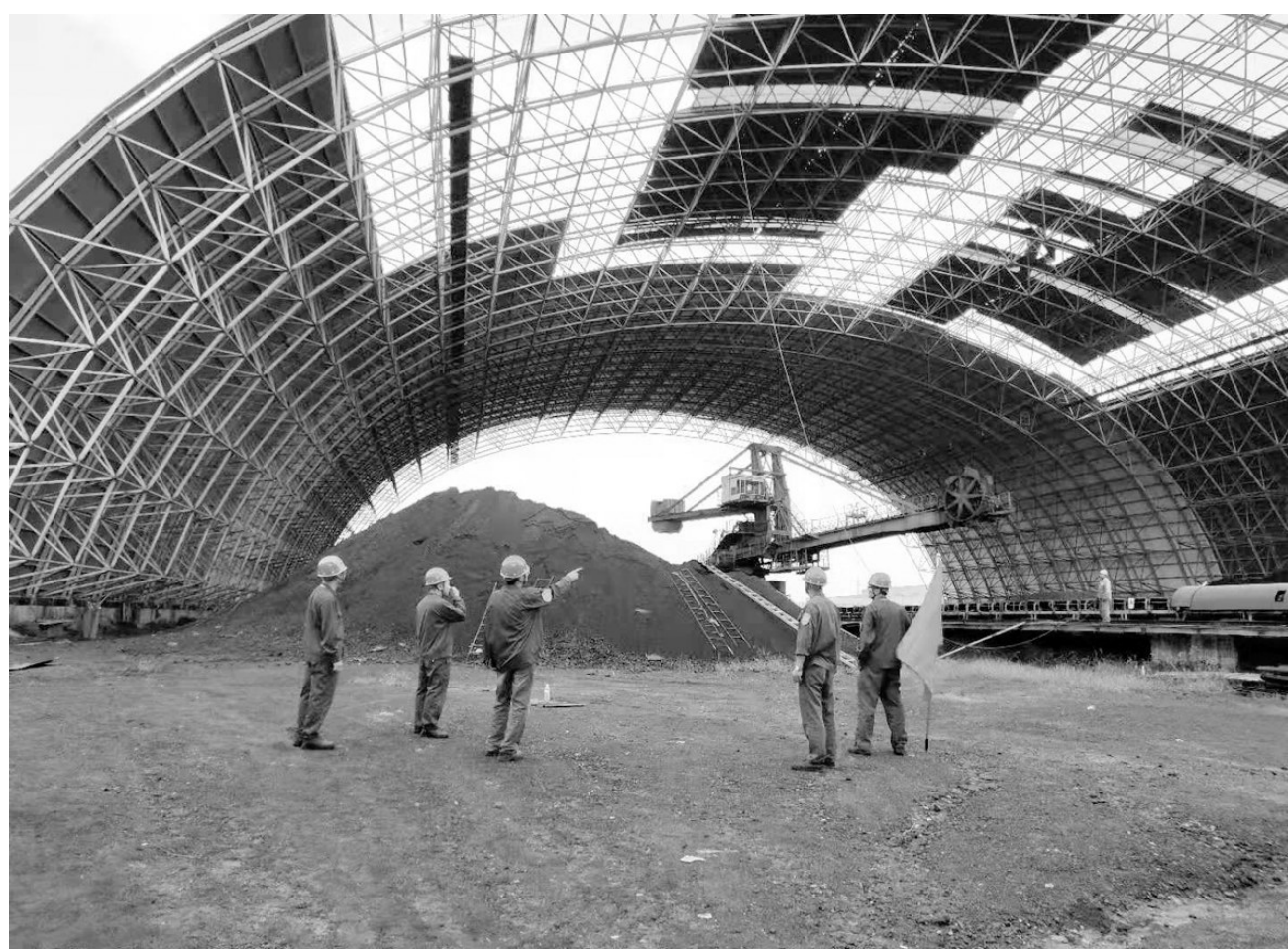
党员安环先锋队进行热电干煤棚施工安全巡查。
