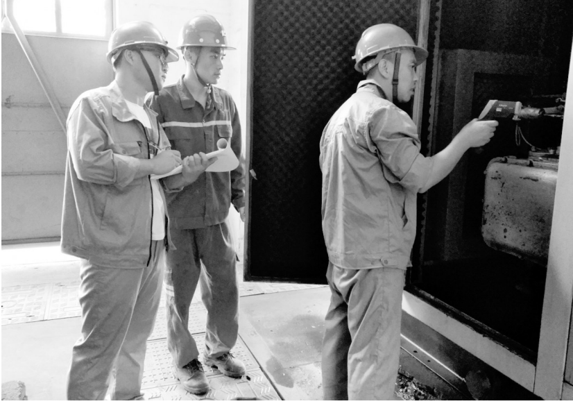
7月30日，铜山铜矿分公司组织专业检测人员对空压机进行安全检测(如图)。据了解，该公司除定期开展设备安全专项检查外，还邀请有资质的单位对设备使用情况进行全面“体检”，确保设备安全高效运行，为矿山安全生产提供有力保障。
