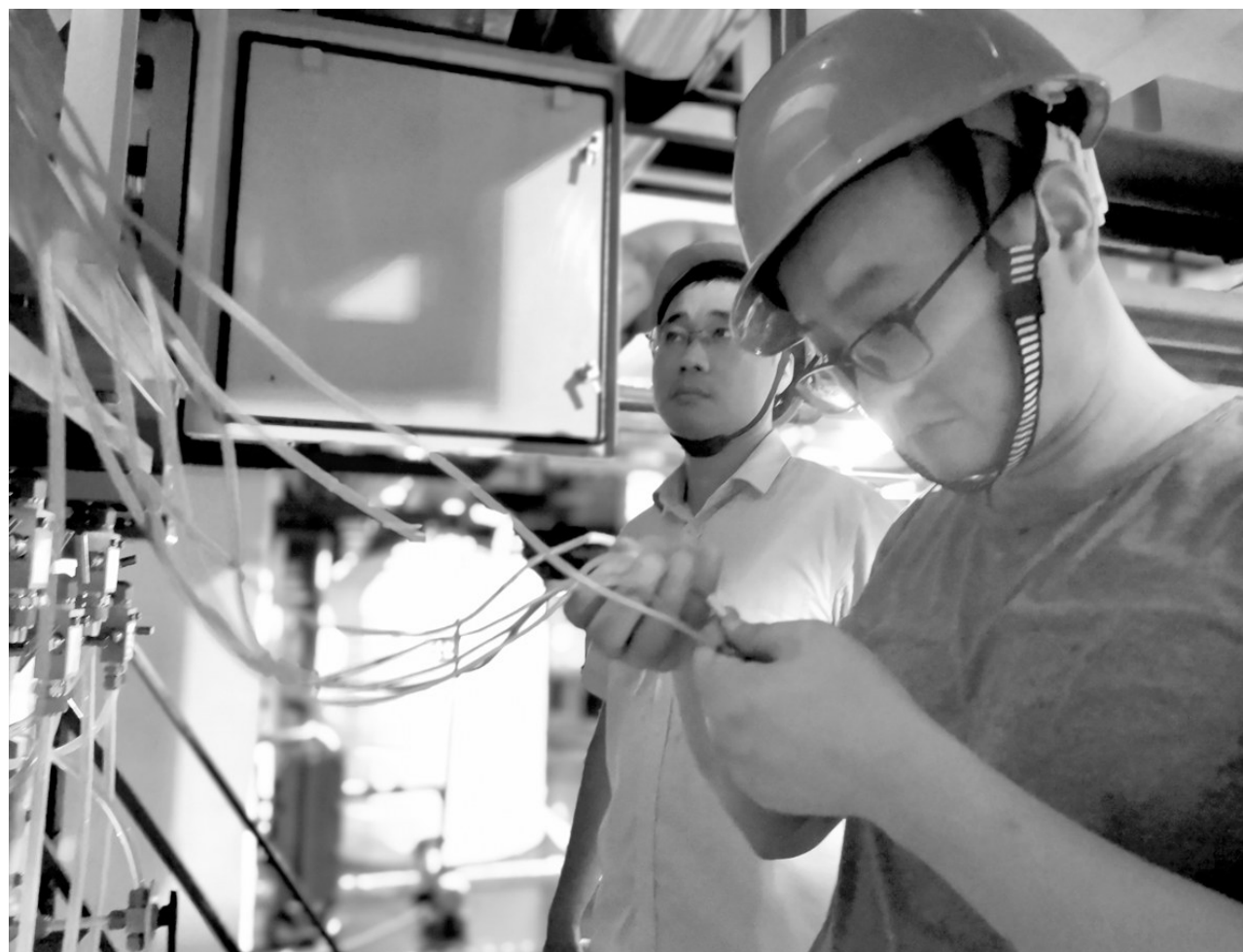
为持续推进公司智能化、自动化进程,日前,铜冠铜箔公司以特种箱配液工段为试点,安装多通道电镀液在线监测仪,调试完成后,该工段将实现溶液离子浓度在线实时检测,从而保证了产品质量的稳定性,还大大降低了人工检测频次。图为安装人员正在调试设备。
