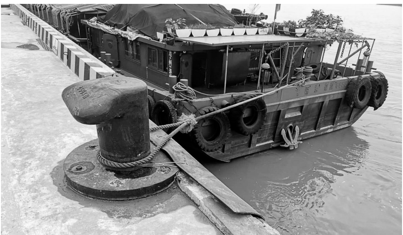
近期,长江水位高涨,码头二道平台通道及缆桩被淹,船舶靠泊后缆绳只能挂在平台上方缆桩上,使缆绳与地面形成夹角,由于水流急,船舶晃动幅度大,缆绳容易断裂。池州铜冠物流分公司想客户所想,剪切码头废旧皮带固定在缆桩边沿,减少缆绳与地面直接接触,从而既保护了缆绳,又保证了船舶在港作业安全。 赵仁兵 摄
