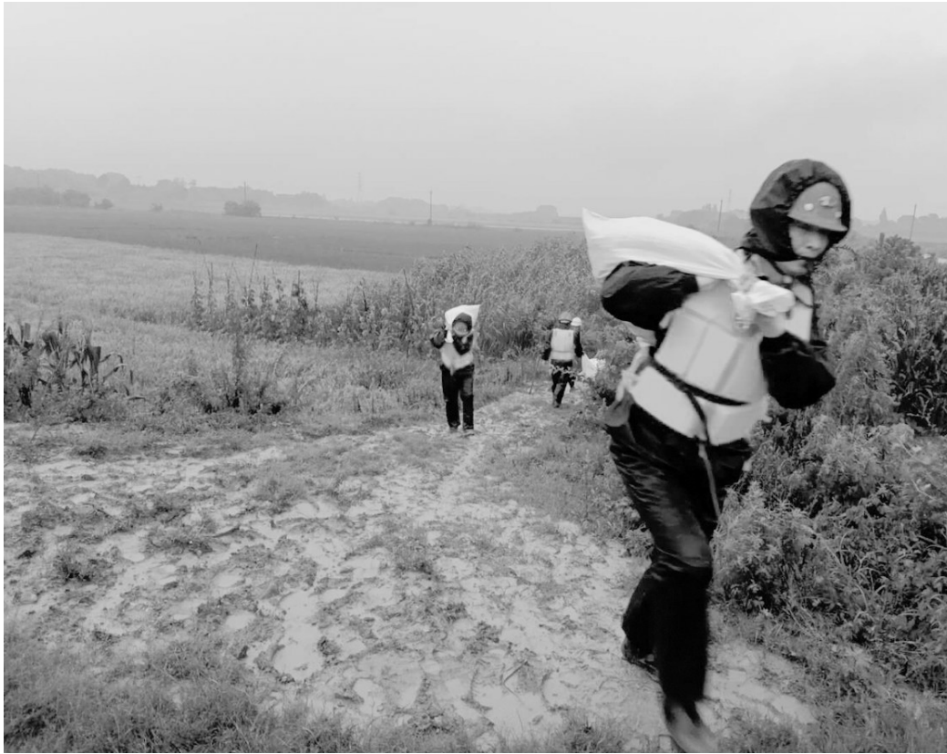
受连续强降雨影响,庐江县泥河镇黄泥河坝水位不断上涨,堤坝漫坝险情随时可能发生。7月18日,接凤凰山矿业公司防洪防汛总指挥命令,该矿铜冠(庐江)充填项目部迅速组织党员干部、积极分子第一时间冒雨奔赴堤坝现场。抢险现场,人员将沙土、石子装进麻袋,一袋袋扛至堤坝加固防洪坝(如图)。连续奋战9个小时后,该项目部筑起了1000多米长、50厘米高的防洪坝,为坝内生命财产安全添加了一道坚固的屏障。 陈幸欣 何 娇 摄
