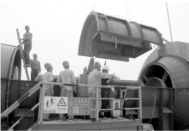
6月30日,铜冠(庐江)矿业公司组织维修人员对北风井主扇风机进行了拆除,以清理、检查其内部零部件。这是该风机自安装以来首次打开进行精密检查,对该大型设备的后期稳定运行和井下通风有重要作用。 陈 潇 黄从娥 摄
