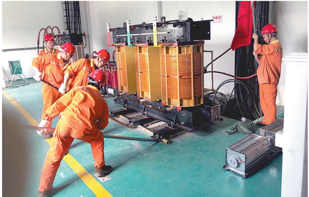
铜冠(庐江)矿业公司主井提升系统的2号定子变压器抵达到现场后,该公司在确保主井不停电、不停运的前提下,组织人员在全面做好安全防护的同时,利用滚杠、撬棍等将8吨多重的变压器移位到安装位置,第一时间恢复主井产能,减轻井下矿废石生产压力。黄从娥 孔艳珍 摄
