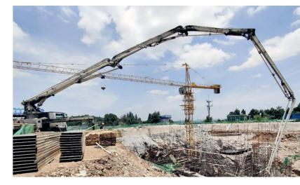
铜冠建安公司第二建筑工程事业部正在冬瓜山铜矿新辅助井井塔工程进行 风道底板浇筑混凝土施工(如图)。该事业部编制专项施工方案 按照施工进度网 络计划组织施工 ,严格把控工程的每个节点 ,有序向前推进。
