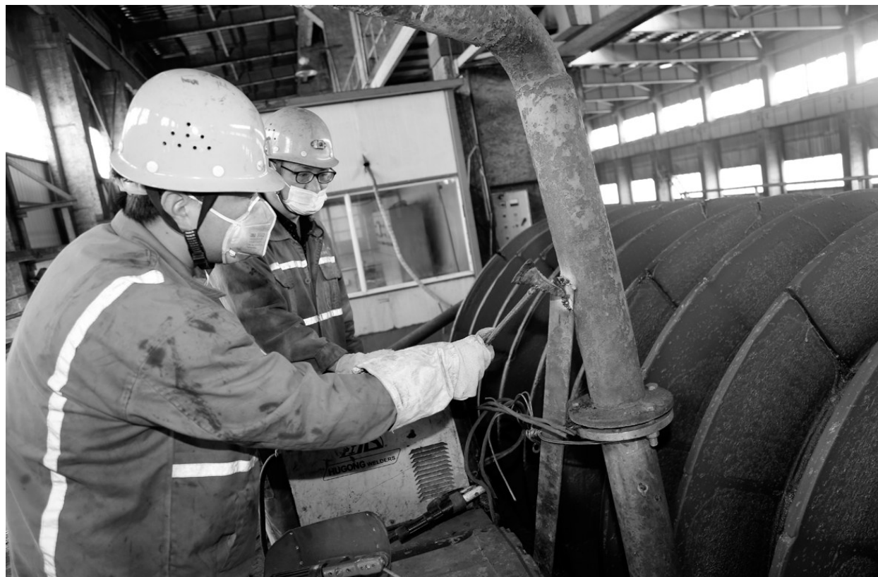
6月10日,冬瓜山铜矿精炼车间维修人员对陶瓷过滤器进料管支架进行固定,防止松动碰撞过滤器造成设备故障。该车间加强设备日常的巡查点检工作,保证设备良好的运行状态,为顺利完成生产任务提供有利的设备保障。1至5月份,该车间超计划完成铜精砂75875.2吨。汤菁 吴小玲 摄
