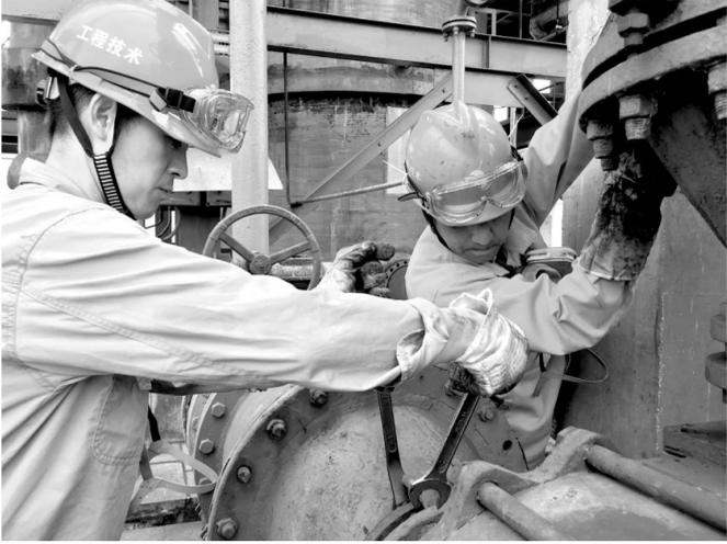
6月3日,工程技术分公司维修技术人员正在铜冠池州公司锌分厂大修现场更换硫酸循环水泵阀门。该公司从金隆项目部抽调了一批精干维修技术力量,自6月1日起奔赴池州公司开展大修施工,并通过强化现场安全施工组织,确保按时间节点完成承接的检修项目。
