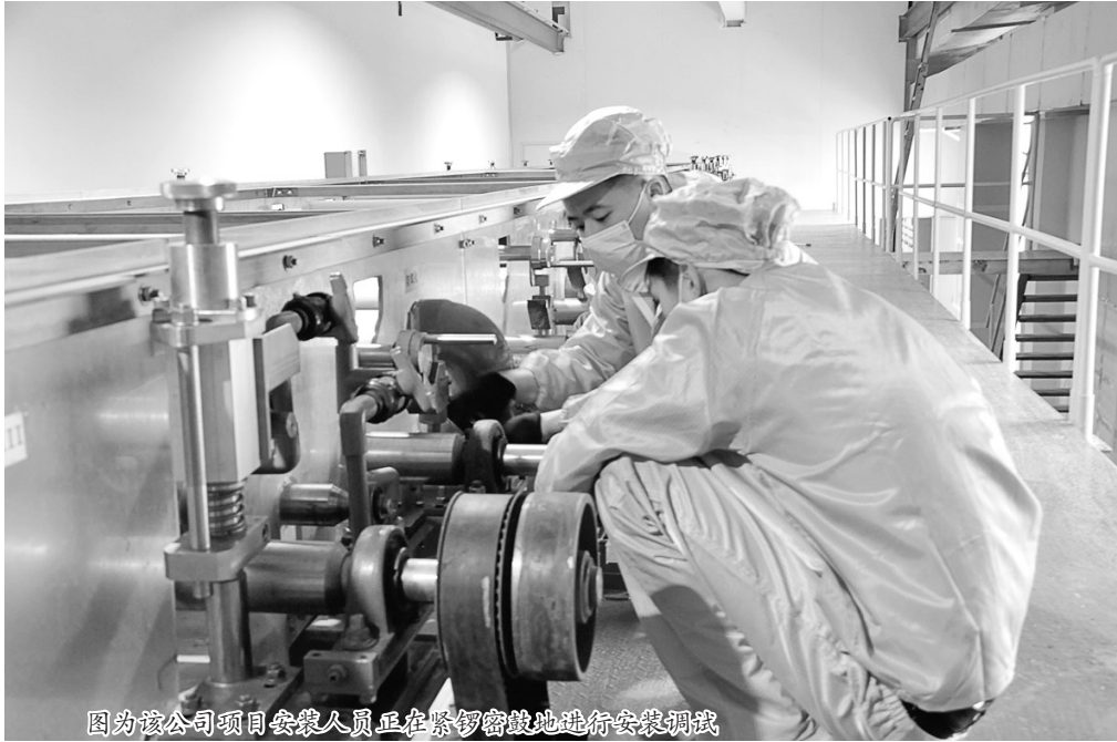
图为该公司项目安装人员正在紧锣密鼓地进行安装调试
