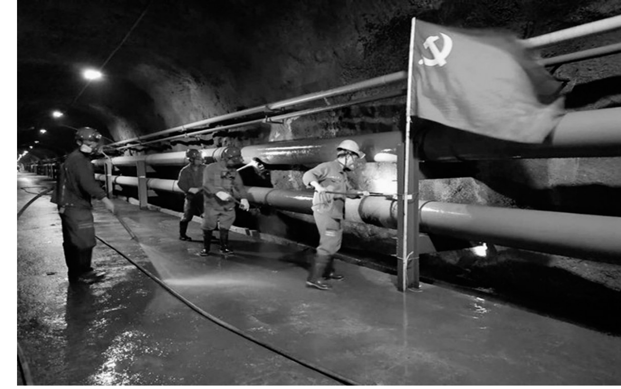
为确保井下安全度汛,冬瓜山铜矿掘进一区党支部组织党员利用生产间隙,对井下负850米主巷等进行了一次集中清理(如图),改善作业环境,保障汛期井下安全生产。
