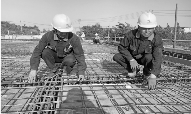
铜冠建安公司第二建筑工程事业部施工班组正在进行钢筋绑扎作业的质量自检。铜冠建安公司第二建筑工程事业部在施工现场狠抓项目的工程质量,坚持做到工程的“三检制”,以确保实现优质的工程质量。王红平 汪锡铜 摄
