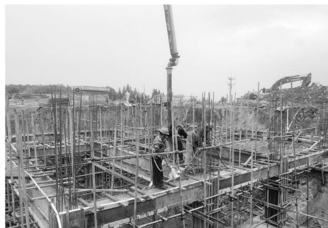
日前,在冬瓜山铜矿新辅助井井塔项目施工现场,铜冠建安公司第二建筑工程事业部职工正在进行配电室基础梁柱的混凝土施工作业(如图)。据了解,为按期交工,该事业部职工加班加点,奋战在各施工现场,抢抓工程进度。
