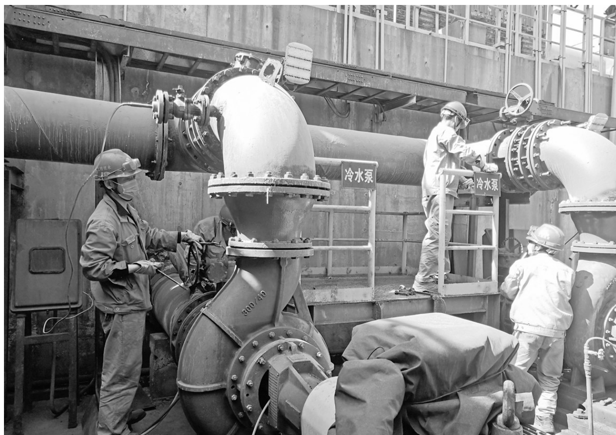
工程技术分公司金冠项目部奥炉综合班员工日前正在抢修作业。该公司金冠项目部奥炉综合班日前接到奥炉冶炼车间抢修奥炉水泵泵坑管道短接、阀门的拆装和清理项目的指令，立即组织检修人员赶赴现场，迅速展开检修。该班员工通过争分夺秒、分工协作，比业主要求时间提前2小时完成抢修任务。 王红平 徐再胜 摄
