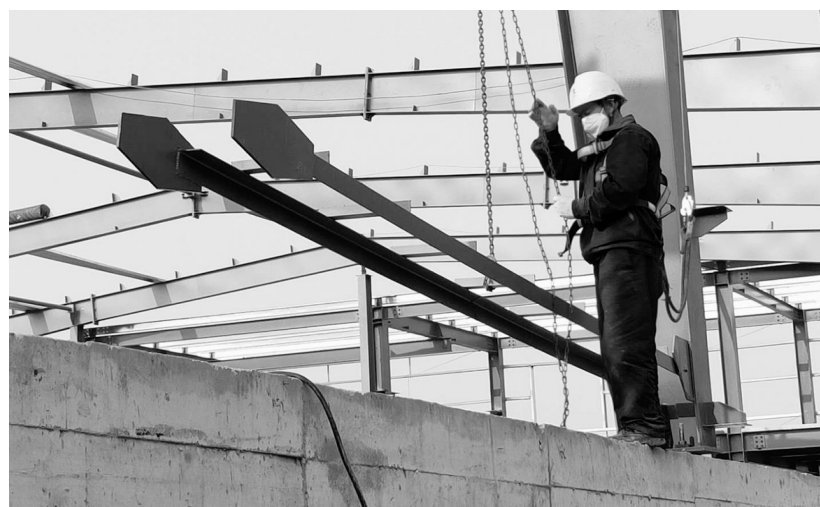
集团公司重点建设工程——铜冠建材公司胶凝新材料二期扩建工程目前正在紧锣密鼓施工中。预计这一工程在5月初基本完工。图为4月13日该工程组织安装钢结构横梁。 江 君 高 明 摄
