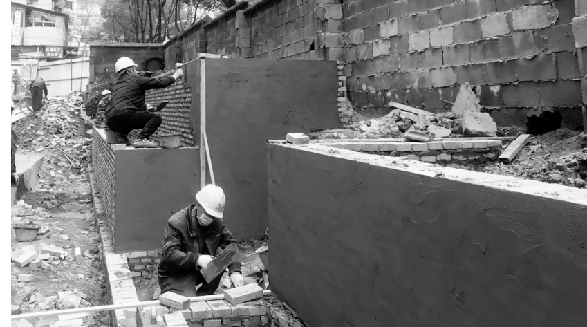
铜冠建安公司第二建筑工程事业部施工人员正在景观工程施工中(如图)。该事业部利用当前晴好天气,在承建的观山名筑住宅8号、9号、商业1至6号楼景观工程中组织员工加紧施工。 王红平 汪锡铜 摄
