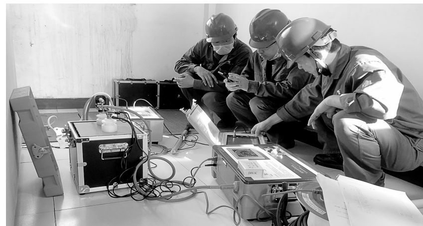
3月25日,电气检测中心检测人员前往动力厂进行电缆故障二次测试(如图)。经电缆故障测距仪反复测试,精准定位到故障点,为下一步故障抢修提供了参考依据。 萨百灵 陈梦秋 摄
