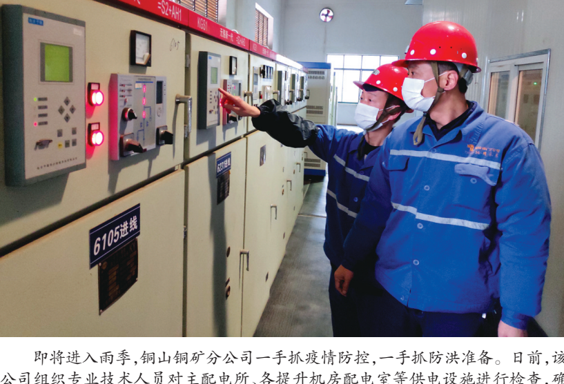
即将进入雨季,铜山铜矿分公司一手抓疫情防控,一手抓防洪准备。日前,该公司组织专业技术人员对主配电所、各提升机房配电室等供电设施进行检查,确保雨季安全运行。图为技术人员在检查主井提升机房配电设施。潘敬虎 摄
