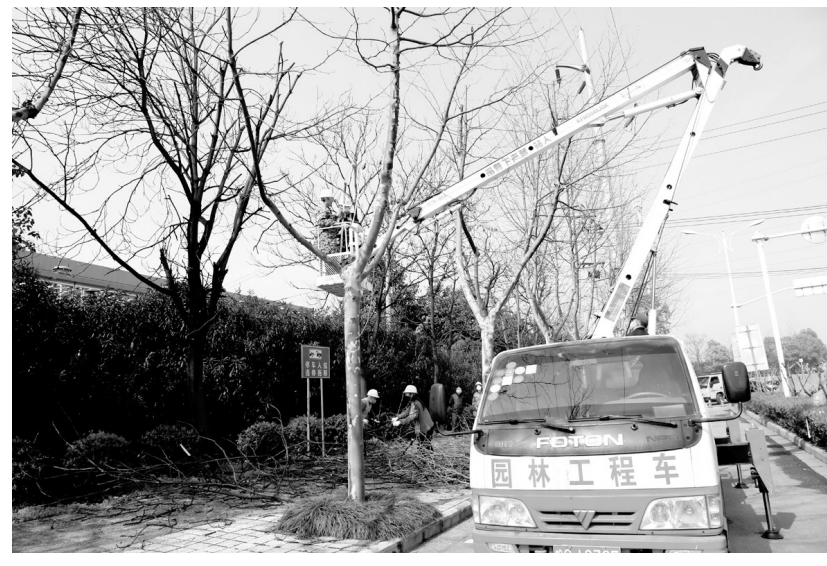
金陵铜业公司利用各种有效方法确保企业用电安全。该公司位于金山路110千伏高压线路下方的景观梧桐树枝超高,容易引发安全事故。该公司机动能源部门积极与市园林局协调树木修剪工作,及时消除隐患,确保供电线路安全畅通。图为园林工人正在修剪超高树枝。
