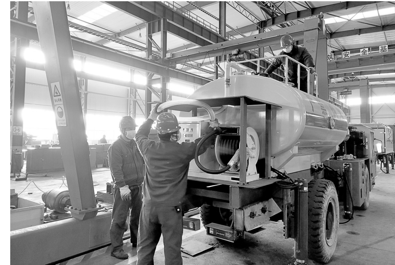
2月14日,铜冠机械公司员工们正在全力以赴安装矿用生产设备(如图)。疫情当前,该公司坚持一手抓新冠肺炎疫情防控,一手抓复工复产。复工后按时完成7台20吨卡车、3台服务车、1台陶瓷过滤器和非标件制作任务。 夏富青 秦 蓉 摄
