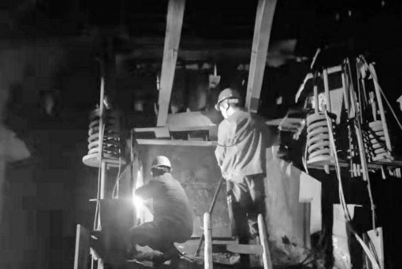
为保证节日生产稳定进行,冬瓜山铜矿运输区大年初四抽调组织精干力量,在生产间隙对负875米58线运输重要设备2号漏斗进行了大修(如图),这次主要是对漏斗全部8副磨损腐蚀的衬板等进行更换,为下一步掘进副产矸石顺利出矿创造了良好条件。
