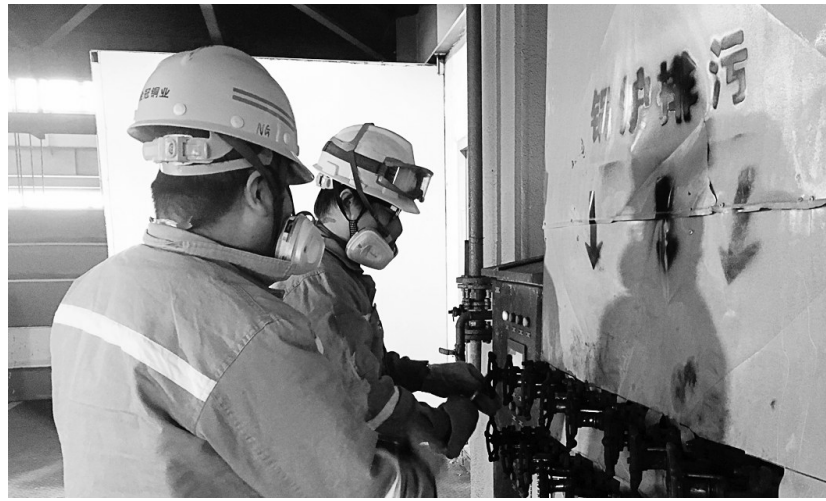
金冠铜业分公司奥炉熔炼车间高度关注现场安全，以“导师带徒”方式保障操作的安全性。图为锅炉操作人员导师的指导下进行集箱排污。
