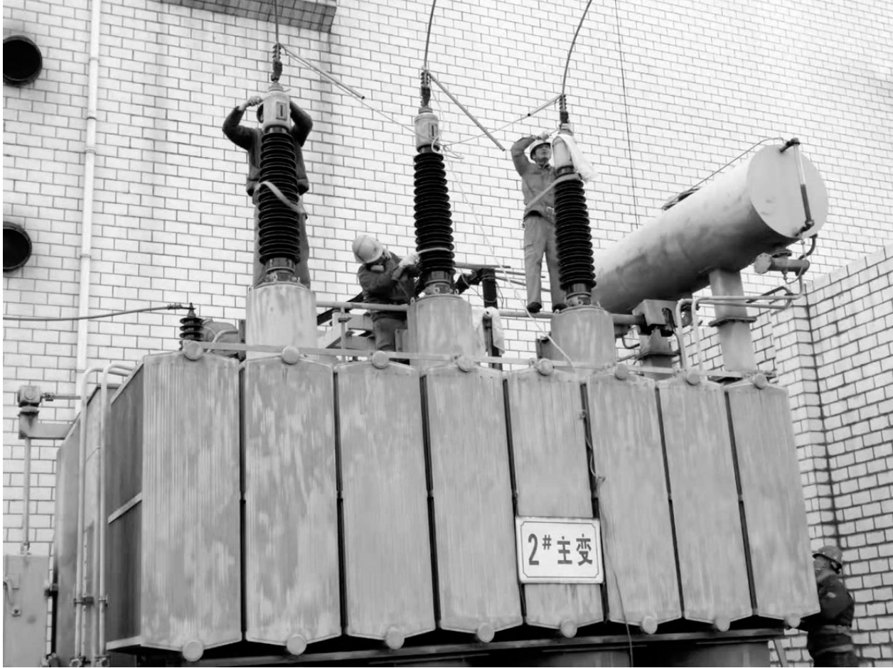
近期,冬瓜山铜矿组织人员在雨雪恶劣天气来袭之前,对矿山供电系统进行一次专项检查,保证雨雪冰冻天气线路畅通,保障矿山安全生产。图为该矿动力车间检修人员对110千伏变电所1号主变进行维护。
