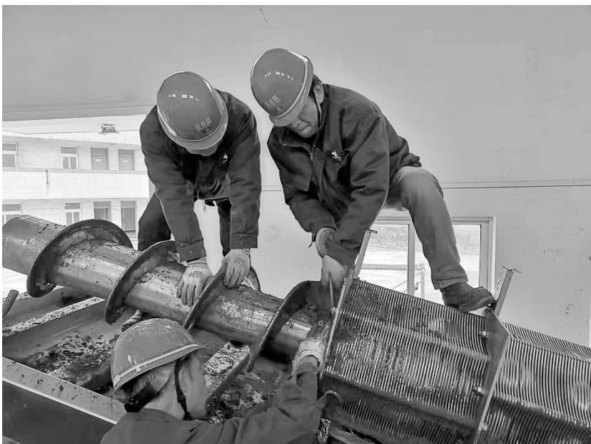
有色动力厂供水排泥处理综合利用工程,是铜陵市“碧水蓝天”工程。为了确保新设备系统正常运行,该厂供水一车间“党员安环先锋队”在设备厂家技术人员指导下,经过三天的艰苦奋战,完成了2号叠螺机抽芯大修工作,确保了排泥生产效果。
