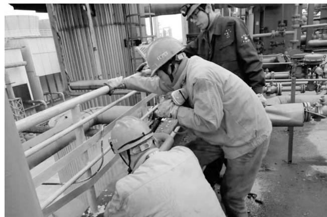
工程技术分公司循环园项目部全泰机械班秉承为业主提供精细维修服务的理念，积极实施设备改造项目。近日，该班组提前一周将管道预制好，制定了详细的施工计划，全员上阵，齐心协力，在保质保量保安全的前提下，按业主要求在5个小时内完成了金泰公司二甲醚车间306卧式釜进料管道整体拆装更换项目，保障了业主单位生产稳定运行。
