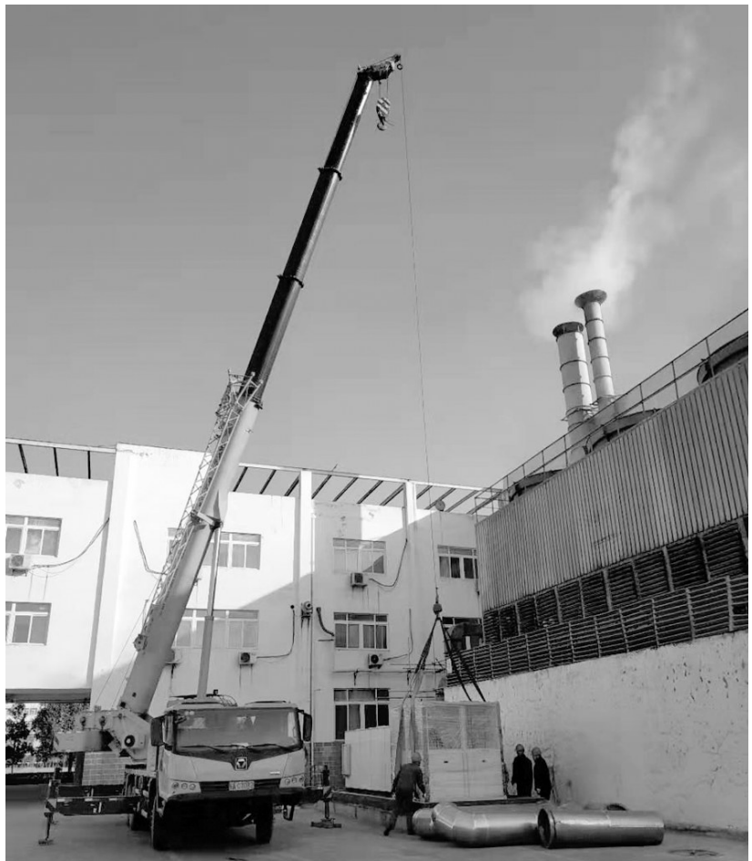
日前,为满足日益严格的环保精细化要求,合肥铜冠国轩公司通过对酸雾处理系统加装尾气降温处理机,将外排热烟气进行冷却,实现酸雾处理排放无烟化。图为技术人员正在进行吊运尾气降温处理机。 许平摄
