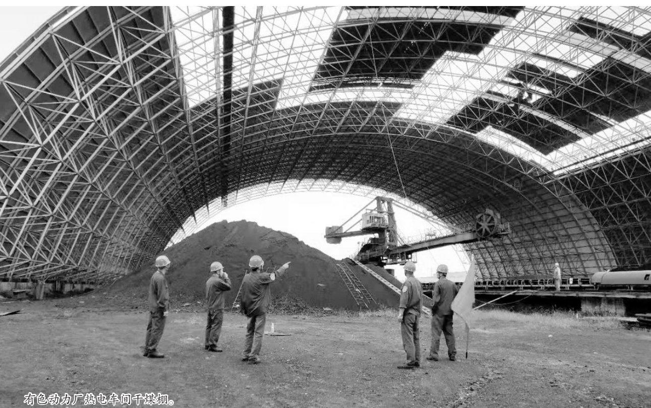
有色动力厂热电车间干煤棚。
