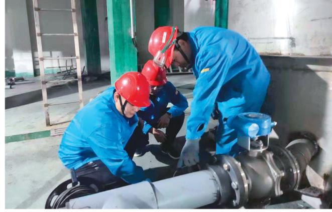
日前,铜陵铜箔公司为了加快产品更新进度,提高产品质量,对溶铜钝化系统实施了更新改造。图为员工正在安装钝化排放阀门。 刘汤青 摄
