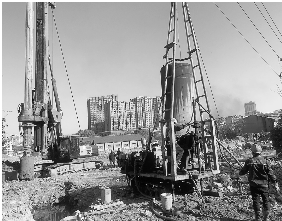
铜冠建安公司施工人员正在进行现场勘探作业。铜冠建安公司承接的宝兴化工地块场地土方工程当前正在抢抓进度向前推进施工,其中超前钻施工作业过半,支护桩已开始施工。
