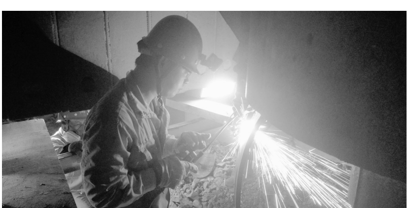
近日,铜冠(庐江)矿业公司技术人员对该动力运转中心负850米中段42-65旋回破碎机设备进行技改。对破碎机底座水泥基础加装钢结构防护,并在MPS油缸外围自主设计安装了保护套,提高了设备运行的可靠性,确保矿山生产安全稳定。
