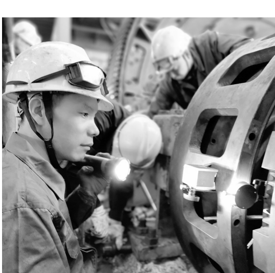
今年以来,铜冠建安安装公司强化技术队伍建设,打造优秀技术人才队伍,对实施维护的业主单位重要设备,以精确到毫米、百分之一毫米精度计算,培养了一大批胜任高精度技术设备维护的技术工匠。图为该公司近日对铜山铜矿分公司球磨机进行维修的场景。
