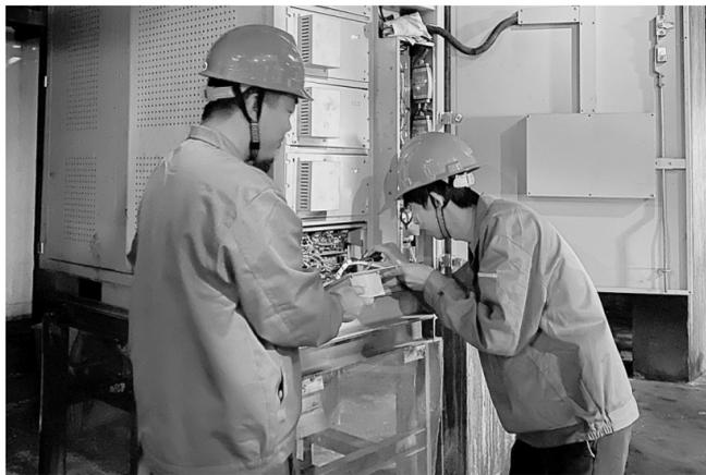
为进一步提高生产效率,日前,铜冠铜箔公司铜箔五六工场决定对生箔机整流柜进行扩容改造,改造后,每台生箔机生产效率提高14.1%。目前已经完成三台生箔机扩容改造。图为维修人员正在对整流柜扩容进行通讯调试。 何亮 吴猛 摄
