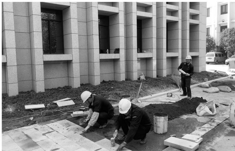
铜冠建安公司施工人员正在铺设人行道面砖。由铜冠建安公司承建的集团公司展示馆及档案馆改造工程项目目前基本完成,现在只剩室外的人行道面砖铺设辅助施工,并即将如期完工,这将为集团公司成立70周年献上一份大礼。 王红平 汪锡铜 摄
